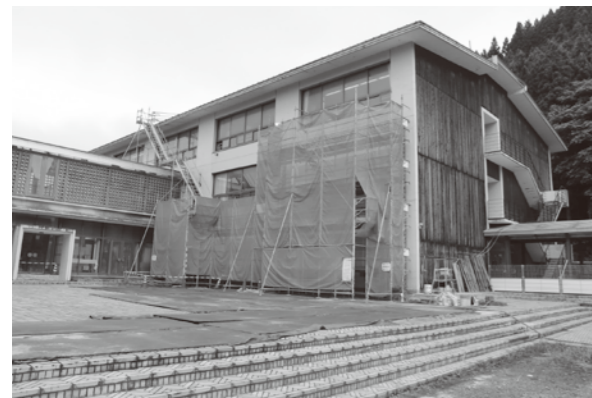
耐震補強工事中の金山小学校
