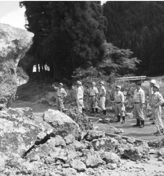
片貝地内の被災現場
