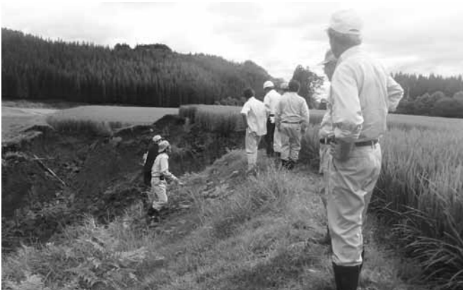
被災した農地を調査
