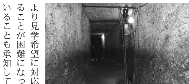
管理されている谷口銀山の坑道
