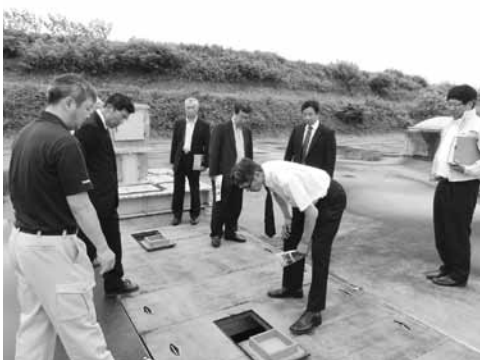
下水処理場現地調査
