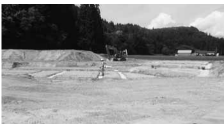
建設中のめごとたま園舎
