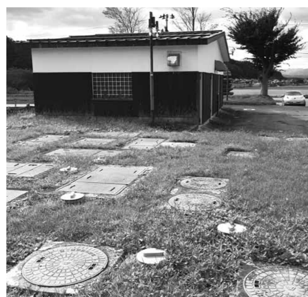
明安地区農業集落排水施設
