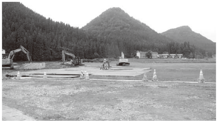
整備順調な貸工場建設地
